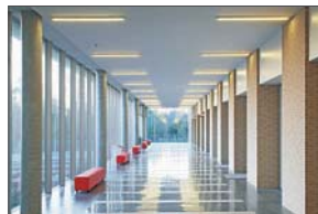
廊下スペースにシームレスLED照明を設置
