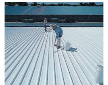
断熱塗装施工の様相
