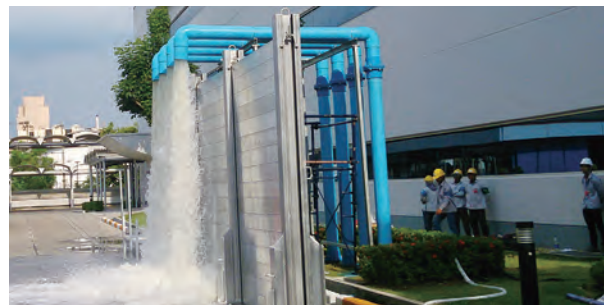
泰国生产网点的BCP演习剪影(挡水墙安装与排水泵启动演习)
