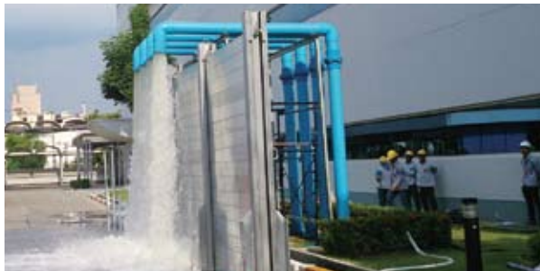
태국 생산 거점에서의 BCP 훈련 (지수벽의 조립과 배수 펌프의 기동 훈련)
