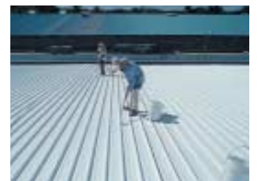
断熱塗装施工の模様
