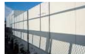
氷蓄熱空調システム
