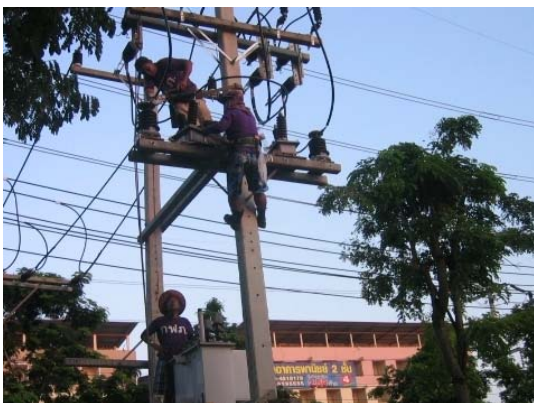
電力会社による電力引き込み工事
