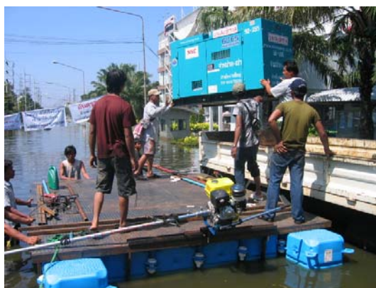
仮設発電機の搬入
