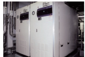
天然ガスボイラー
