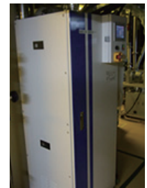
VOC除害装置
