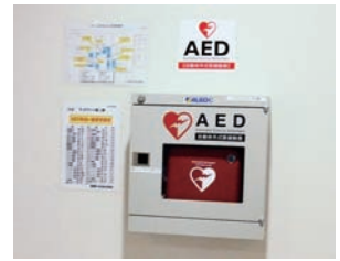
AED設置事例
