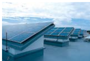
ローム・アポロ 太陽光発電施設 年間2万4千kwhの発電能力
