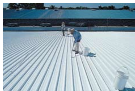
断熱塗装施工の様相
