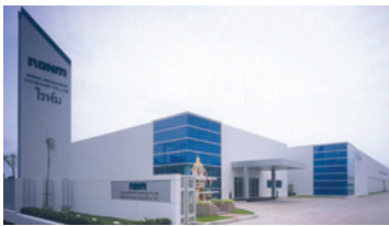
■製造品目 金型、リードフレーム
