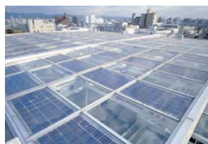
ローム本社 太陽光発電施設 年間1万1千kwhの発電能力
