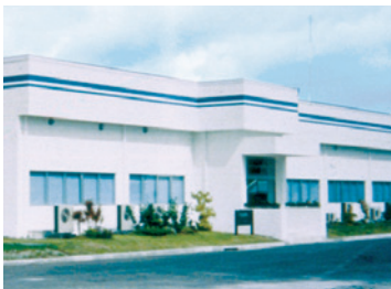
■製造品目 金型、リードフレーム
