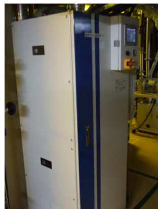
VOC除害装置
