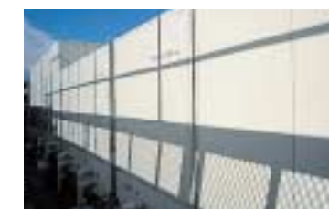
氷蓄熱空調システム
