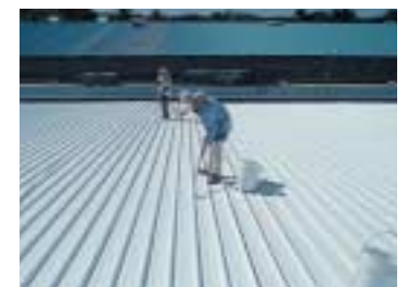
断熱塗装施工の様相
